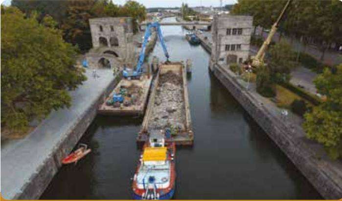
En Wallonie, la démolition des arches du Pont des Trous de Tournai a été menée lors de l'été 2019, afin de faciliter le passage de bateaux de plus grande taille. Il s'agissait de l'un des derniers goulets d'étranglement sur les 450 km de voies navigables wallonnes, au cœur du réseau Seine-Escaut. Que les amoureux du patrimoine se rassurent. Seules les tours datent du Moyen-Âge, les arches, détruites pendant la Seconde guerre mondiale, dataient de 1948. (DR : www.scaldistournai.eu)
